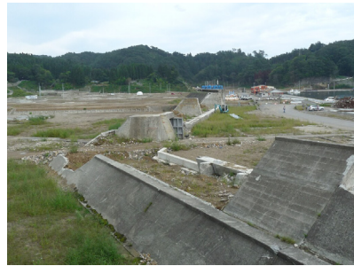
(d) Collapsed dike in Taro City
